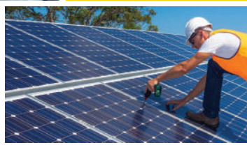
ABB ve ANTRAY Binalarına Çatı Tipi GES
